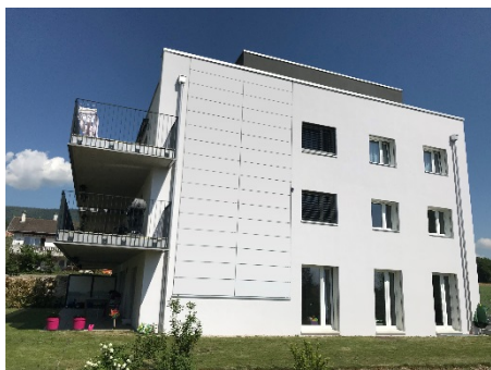
Les éléments photovoltaïques qui recouvrent cette façade s'adaptent aux exigences esthétiques, avec ici une première démonstration de façade photovoltaïque blanche. (Réalisée par Solaxess sur la base d'une technologie CSEM, partenaires du projet Be-Smart)
