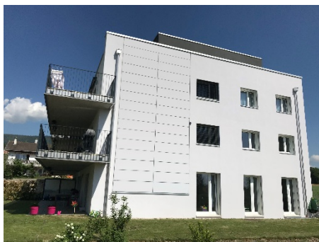
Die Photovoltaikmodule an dieser Fassade passen sich den ästhetischen Anforderungen hier mit einer ersten Demonstration einer weissen Photovoltaikfassade an. Realisiert von Solaxess mithilfe einer Technologie von CSEM. Beide sind Partner des Be-Smart-Projektes)
