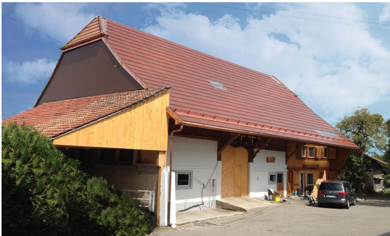
Eine Solaranlage mit ziegelroten Photovoltaikmodulen: das Pilotprojekt in Ecuwillens, FR (Schweiz)
