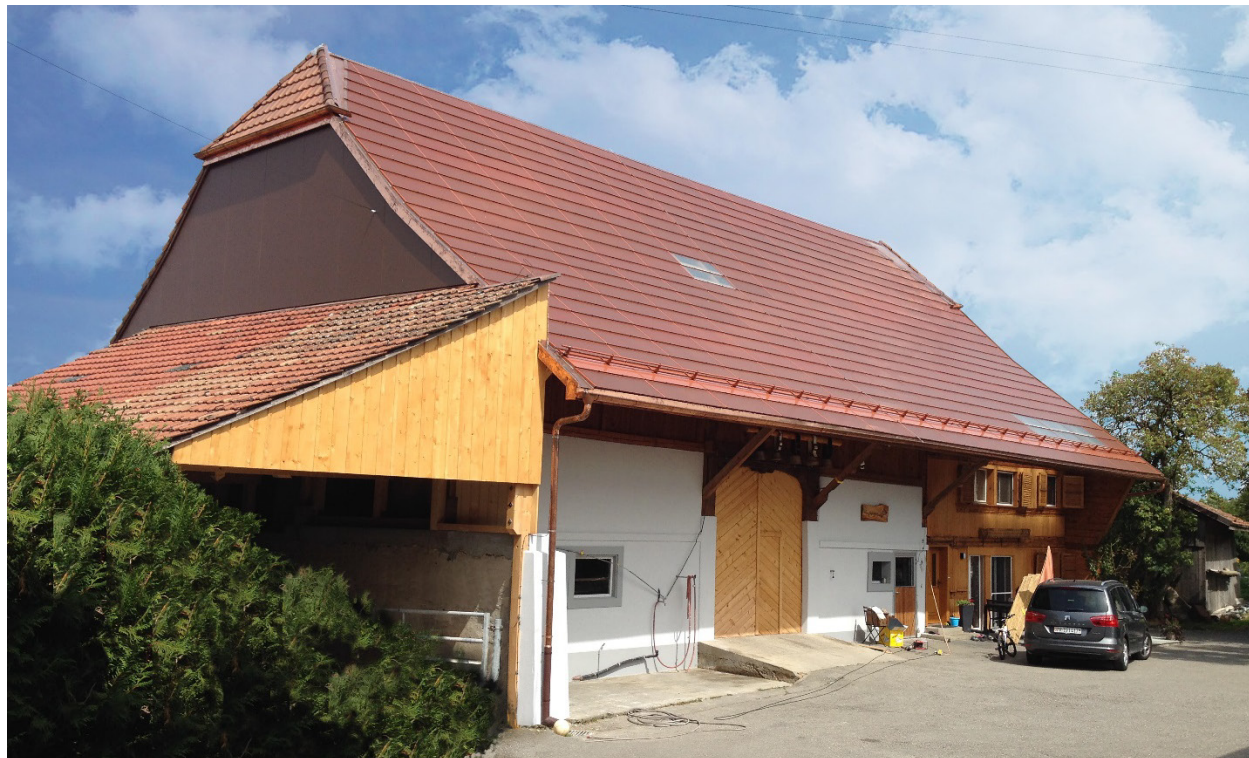
Exemple d'intégration parfaite: panneaux solaires de couleur rouge terre cuite, projet pilote d'Ecuillens, Canton de Fribourg (CH)
