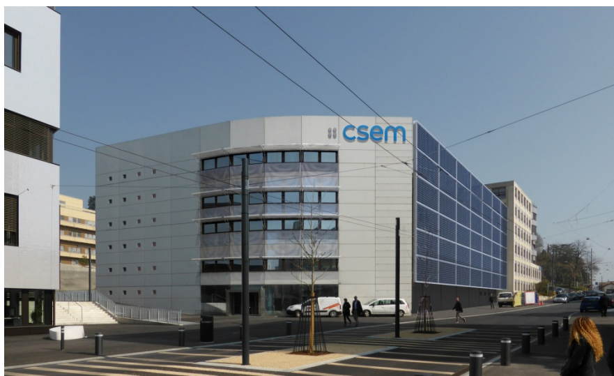
Nouveaux panneaux solaires en façade, Maladière 83, Neuchâtel, © GD-Archi.ch
